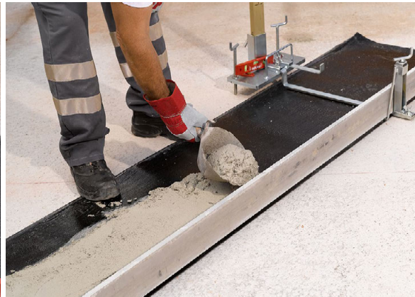
VERARBEITUNG MAUERWERK MIT DÜNNBETTMÖRTEL
