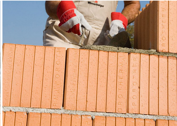
VERARBEITUNG MAUERWERK MIT NORMALMAUERMÖRTEL/WÄRMEDÄMM-MAUERMÖRTEL
