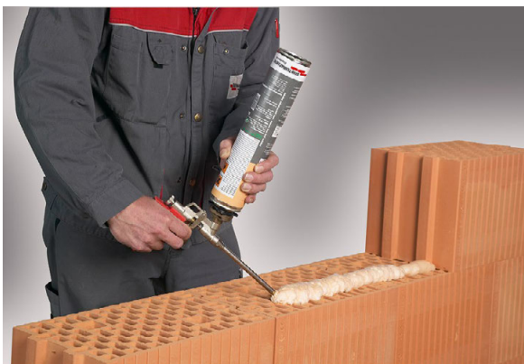
VERARBEITUNG VON MAUERWERK MIT PLANZIEGELKLEBER
