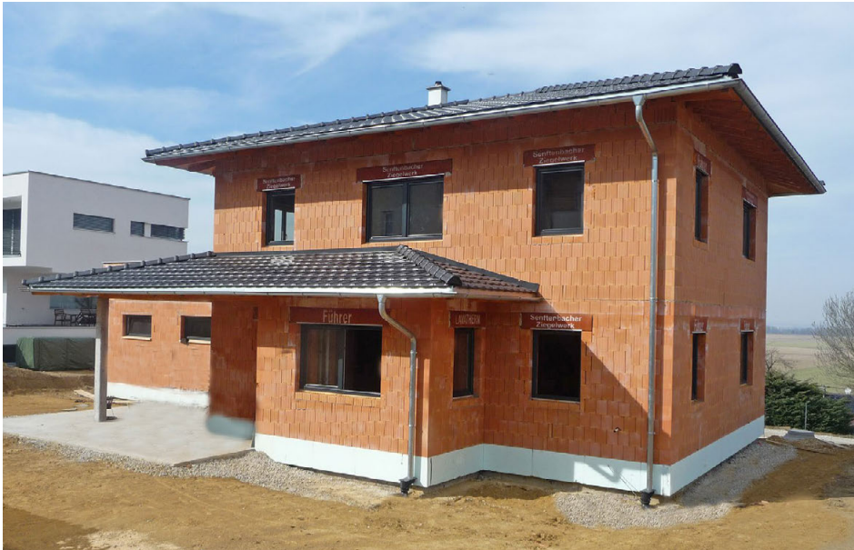
KLEINVOLUMIGER ZIEGELROHBAU MIT PLANZIEGELMAUERWERK
