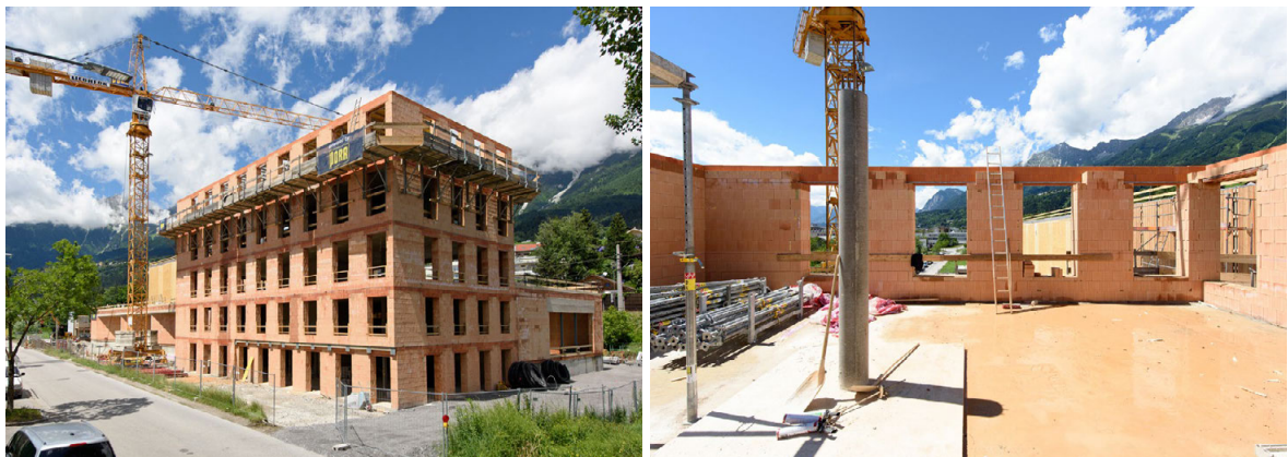
ROHBAU INTERPARK FOCUS 40, RÖTHIS, MONOLITHISCHE AUSSENWAND 50 CM
