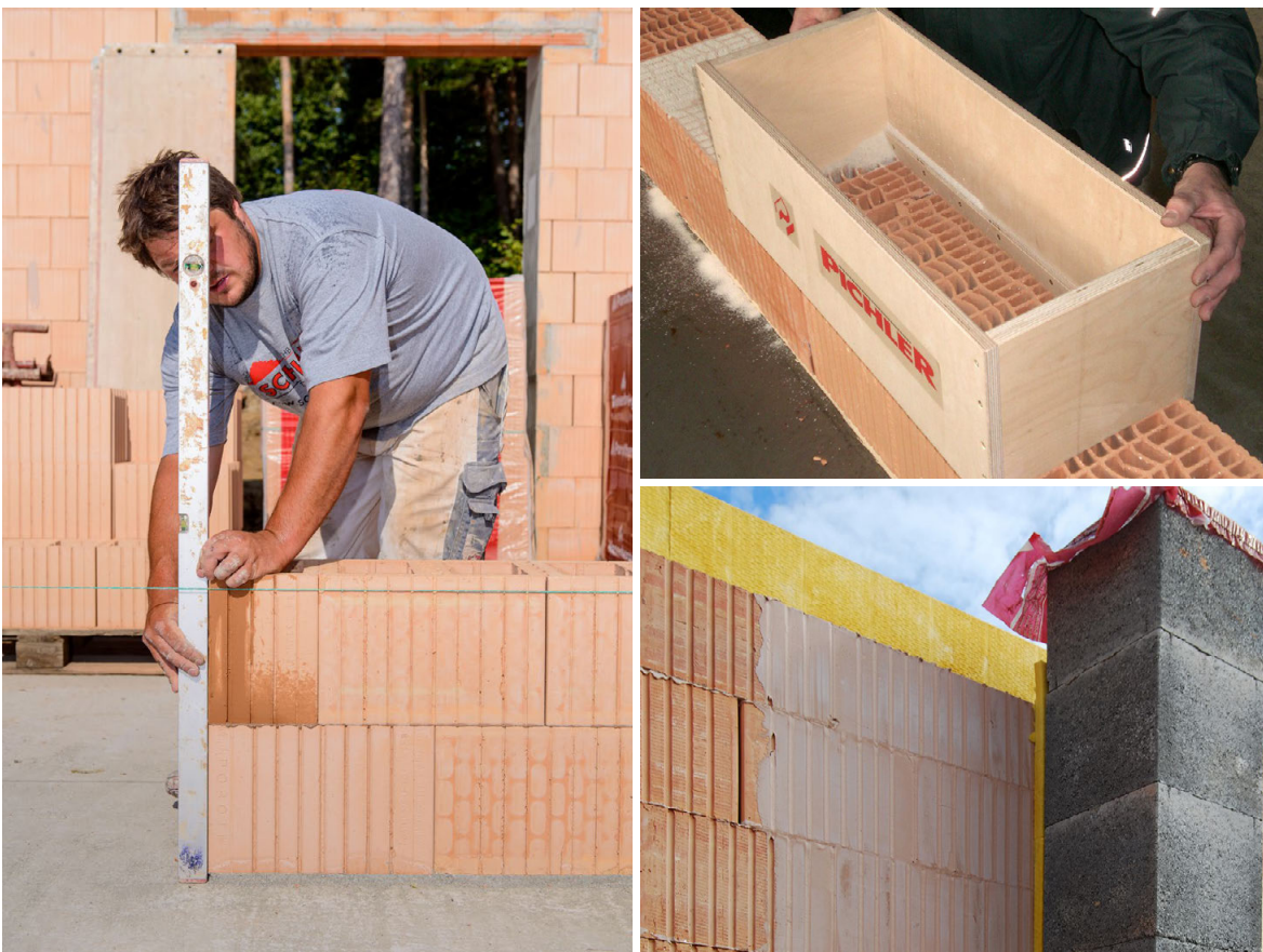
AUFMAUERUNG WANDZIEGEL, AUSBILDUNG THERMOFUSS UND ANSCHLUSS KAMIN
