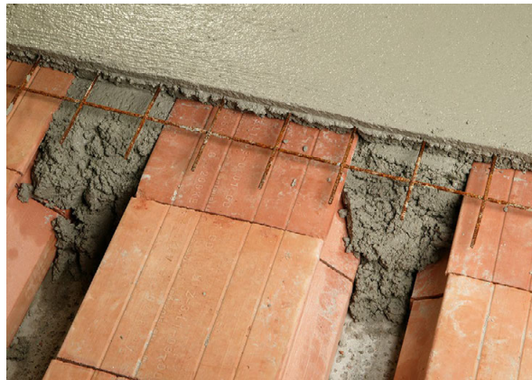
ZIEGELDECKE MIT AUFBETON
