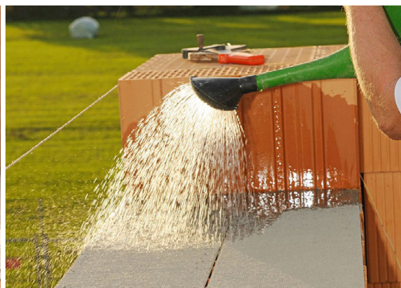
VERARBEITUNG MAUERWERK MIT ROLLMÖRTEL
