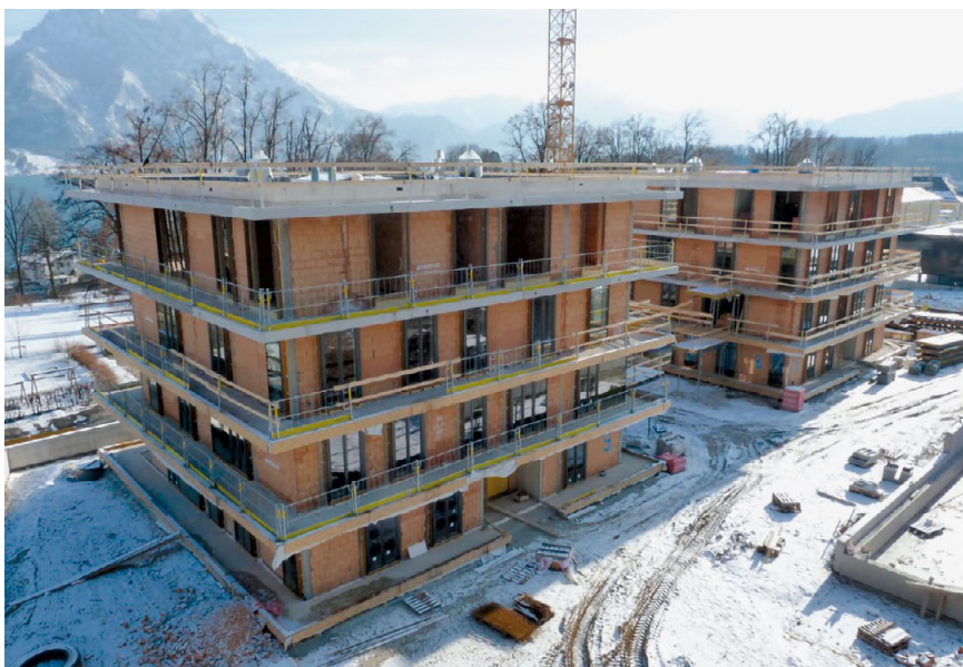
ROHBAU PARKVILLEN INNSBRUCK
