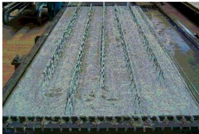
Das fertig betonierte Element, bereit für die Auslieferung.
