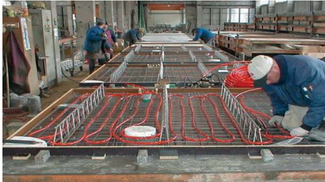
Gleichbleibende Qualität durch industrielle Fertigung im Betonwerk
